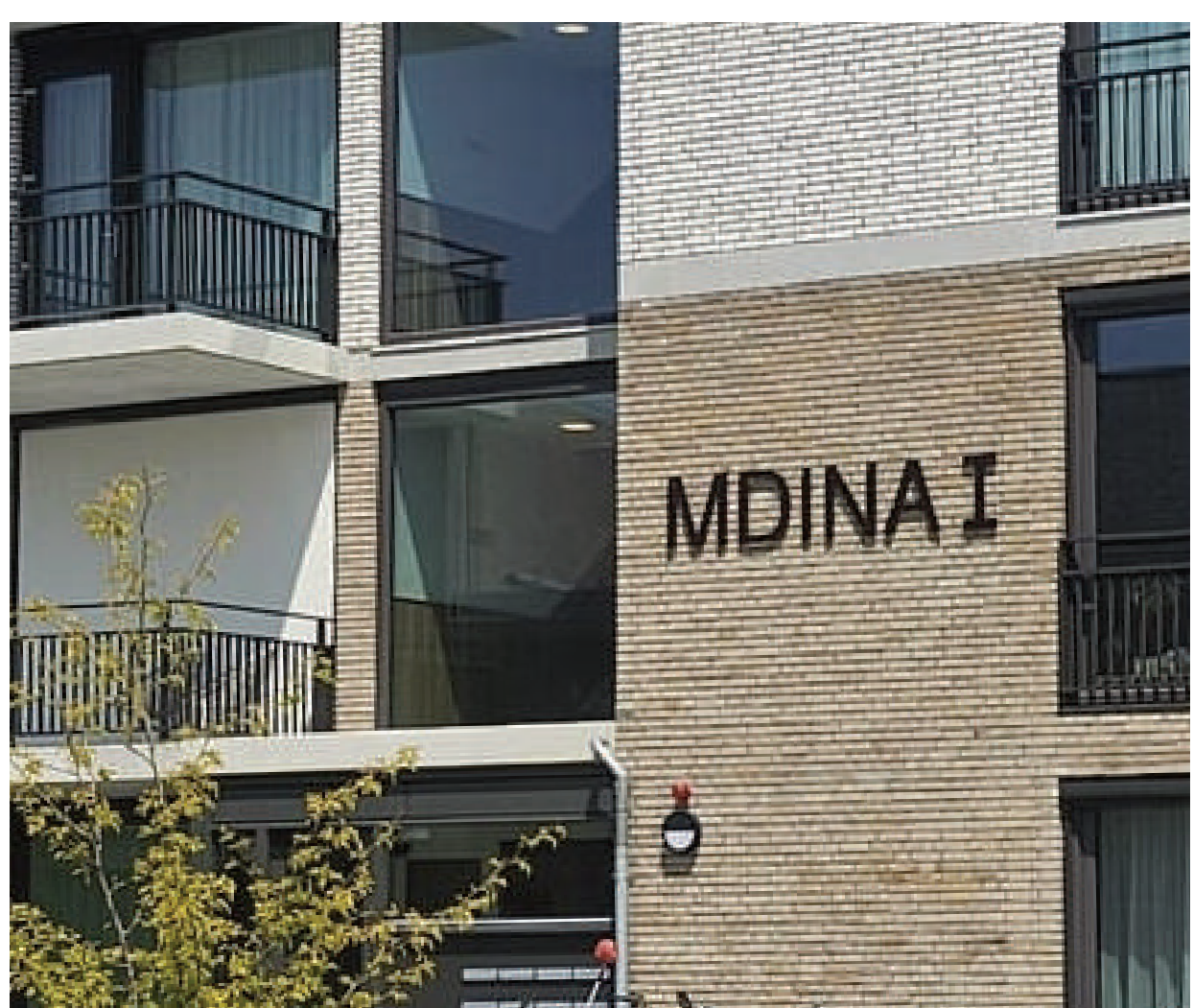
meerkleurig (bij kop mogelijk 3 tinten), om de geleding van de volumes te articuleren
